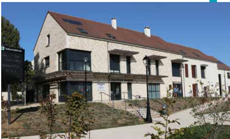
Maison médicale et laboratoire de biologie situés 2 av. des Platanes
